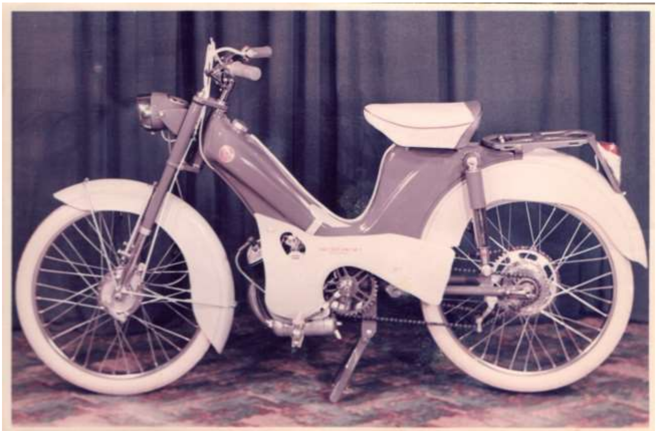
GR L6 cadre poutre selle ceyla très confortable boîte à outil incorporée dans la cadre. Fourche télescopique suspensions AR oscillante grand débattement compteur incorporé version 2 tons gris.
